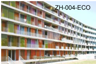
ZH-004-ECO Brunnenhof Zürich, Stiftung Wohnsiedlungen für kinderreiche Familien Gigon/Guyer Architekten, Zürich
